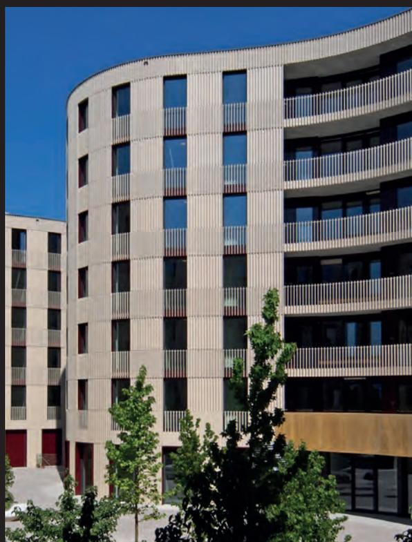
Le montage vertical des plaques de façade de grand format gagne en importance. De plus en plus d'architectes planifient et conçoivent des façades comportant des joints visibles orientés verticalement. C'est pourquoi NBK a développé une sous-structure spécifique, permettant un montage sans effort des plaques orientées verticalement. Comme pour le montage horizontal, les plaques sont également librement suspendues et ne nécessitent pas de support intermédiaire.
