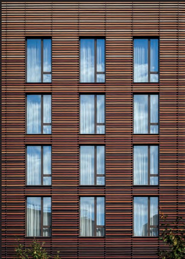
Le système de fixation latérale (side fixing solution) utilise les alvéoles latérales induites par la production des baguettes. Ainsi, un façonnage mécanique supplémentaire des baguettes n'est pas nécessaire.
