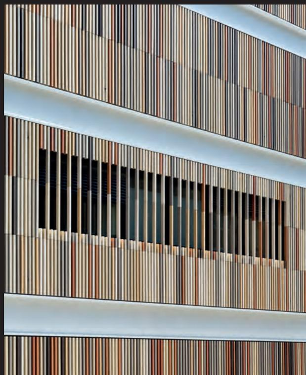
La solution de fixation par l'arrière (back fixing solution) requiert deux perforations supplémentaires sur l'arrière des baguettes pour la fixation du support correspondant.
